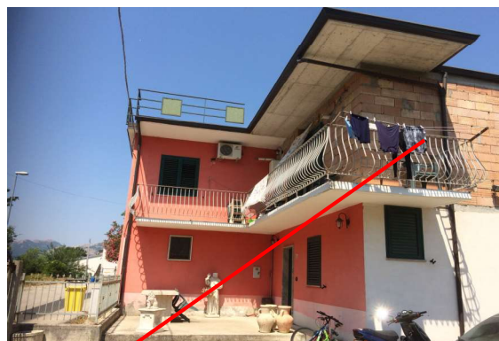
Costruzione da demolire
