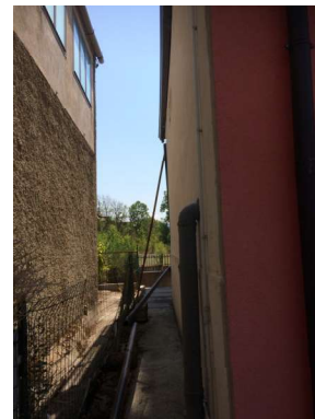
Recinzione al confine
