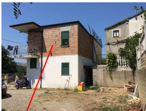
Costruzione da demolire
